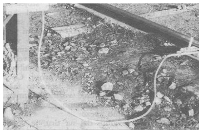
Slika 40: Začasna vez med kovinsko konstrukcijo in z ustreznim sistemom zaščite na odseku – primer za ozemljitev odra
