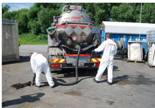
Iz kanala se izčrpa tekočino v cisterno
